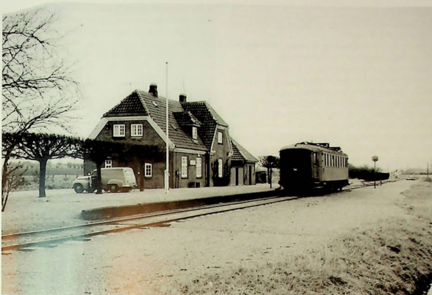
Stationerne var ens og næsten ikke ændret siden 1911, her i 1966 Kustrup Station med et holdende motordieseltog på vej til Brenderup. Bemærk de formklippede træer og i baggrunden vigesporer med nogle holdende, åbne godsvogne. Toget er et MD3, som normalt trak godstogene og de store persontog, men kunne også køre solo. (Foto: Hans Gerner Christiansen, som også har bidraget med oplysninger om togene)
