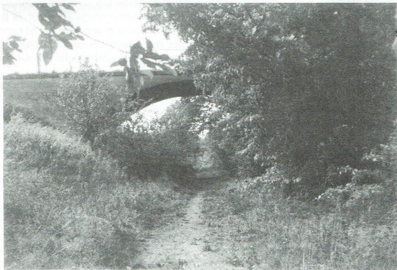
Viadukten på Strib Landevej, nu med idyllisk natursti på Røjlegrisens tidligere spor.
