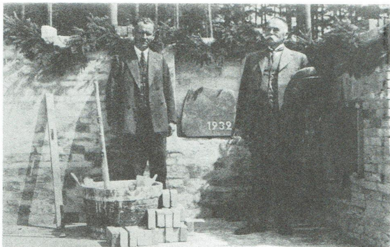
FDBs formand, L. Broberg, og forstander L. A. Godsk ved grundstensnedlæggelsen den 13. juli 1932.
